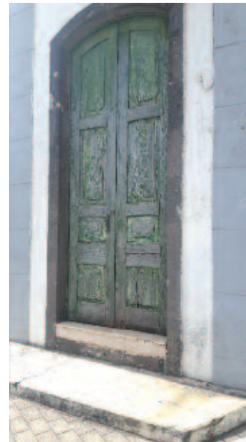
Situación del Descansadero en el cruce de la calle Perojo y Párroco Marrero Díaz.
