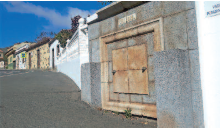
Descansadero del cruce de caminos en Fuente La Rosa.
