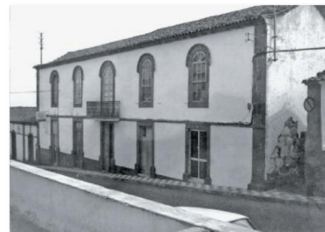
Edificio del antiguo ayuntamiento. Año 1982. Fuente: FEDAC.
