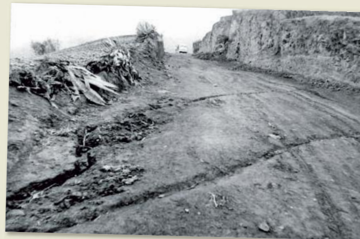
Arranque en el trazado de la carretera de Madrelagua.
