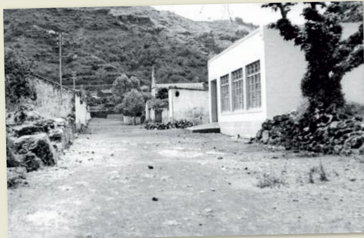
Calle principal de Valsendero. La escuela aparece en primer término a la derecha, al fondo podemos apreciar la Parroquia de San Luis Gonzaga. La foto es de finales de los años 50 del pasado siglo.
